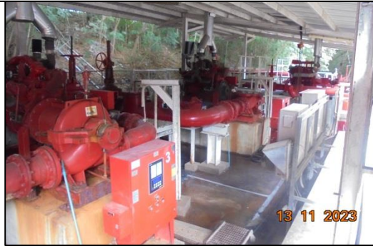
เครื่องยนต์ขับเคลื่อนน้ำดับเพลิงชนิดทวนน้ำทะเล
