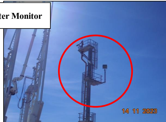
ระบบ Fixed Water Spray ชนิดทวนน้ำทะเล
