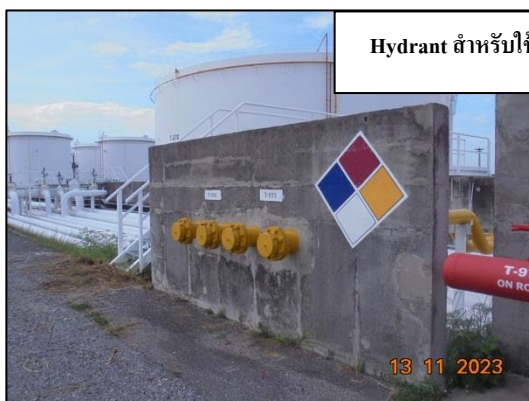
รูปที่ 9 ระบบดับเพลิงภายนอกอาคารใช้โฟมสำหรับดับเพลิง
