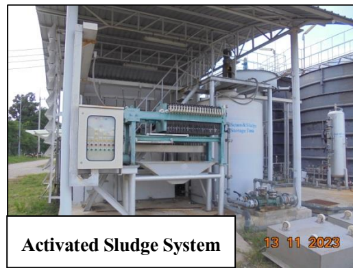
รูปที่ 2 ระบบบำบัดน้ำทิ้งปนเปื้อนน้ำมันจากกระบวนการขนถ่ายน้ำมัน
