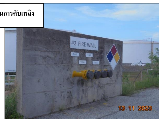
รูปที่ 9 ระบบดับเพลิงภายนอกอาคารใช้โฟมสำหรับดับเพลิง
